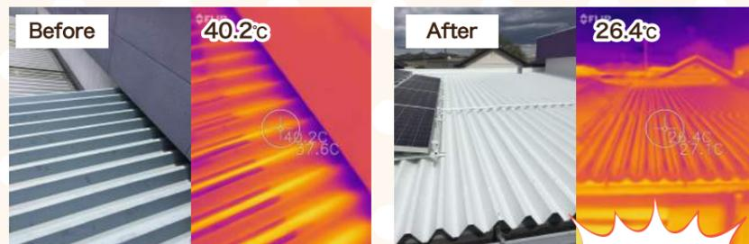
物体に当たった光は、反射か吸収のいずれかの経路をたどります。物体表面で「反射」した赤外線が熱に変換されることはありませんが、「吸収」した赤外線は即座に熱へと変換されるため、赤外線をしっかり「反射」することは、室内温度の上昇を抑制するのに効果的な方法と言えます。
